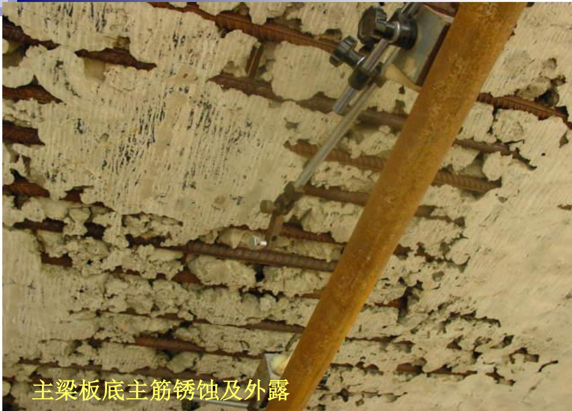
主梁板底主筋锈蚀及外露
