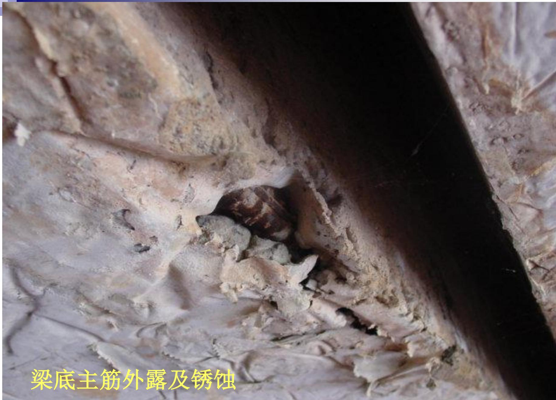
梁底主筋外露及锈蚀
