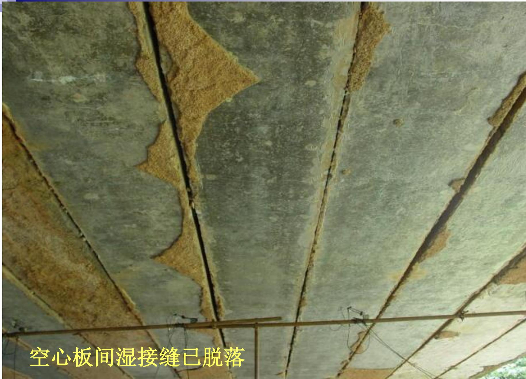
空心板间湿接缝已脱落
