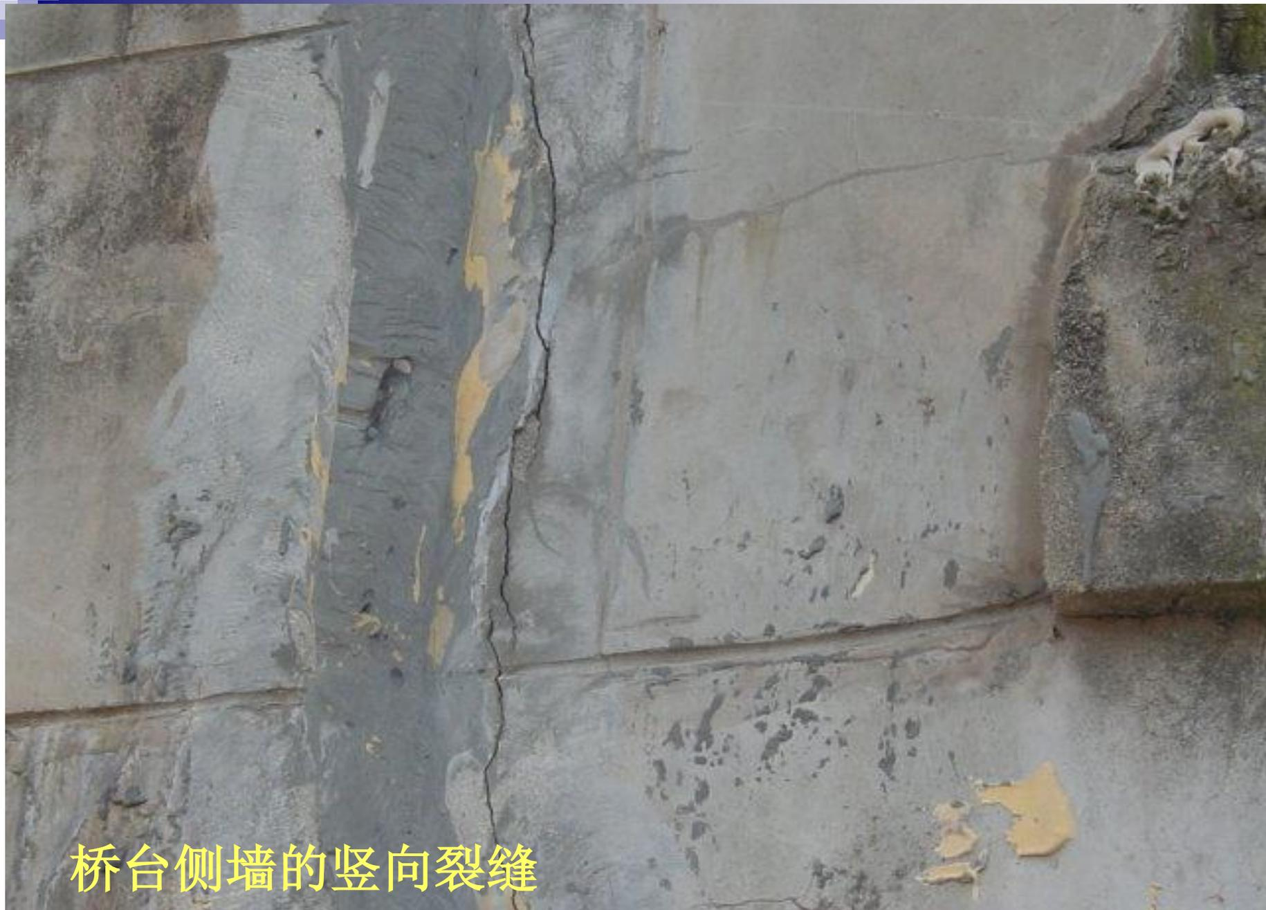
桥台侧墙的竖向裂缝
