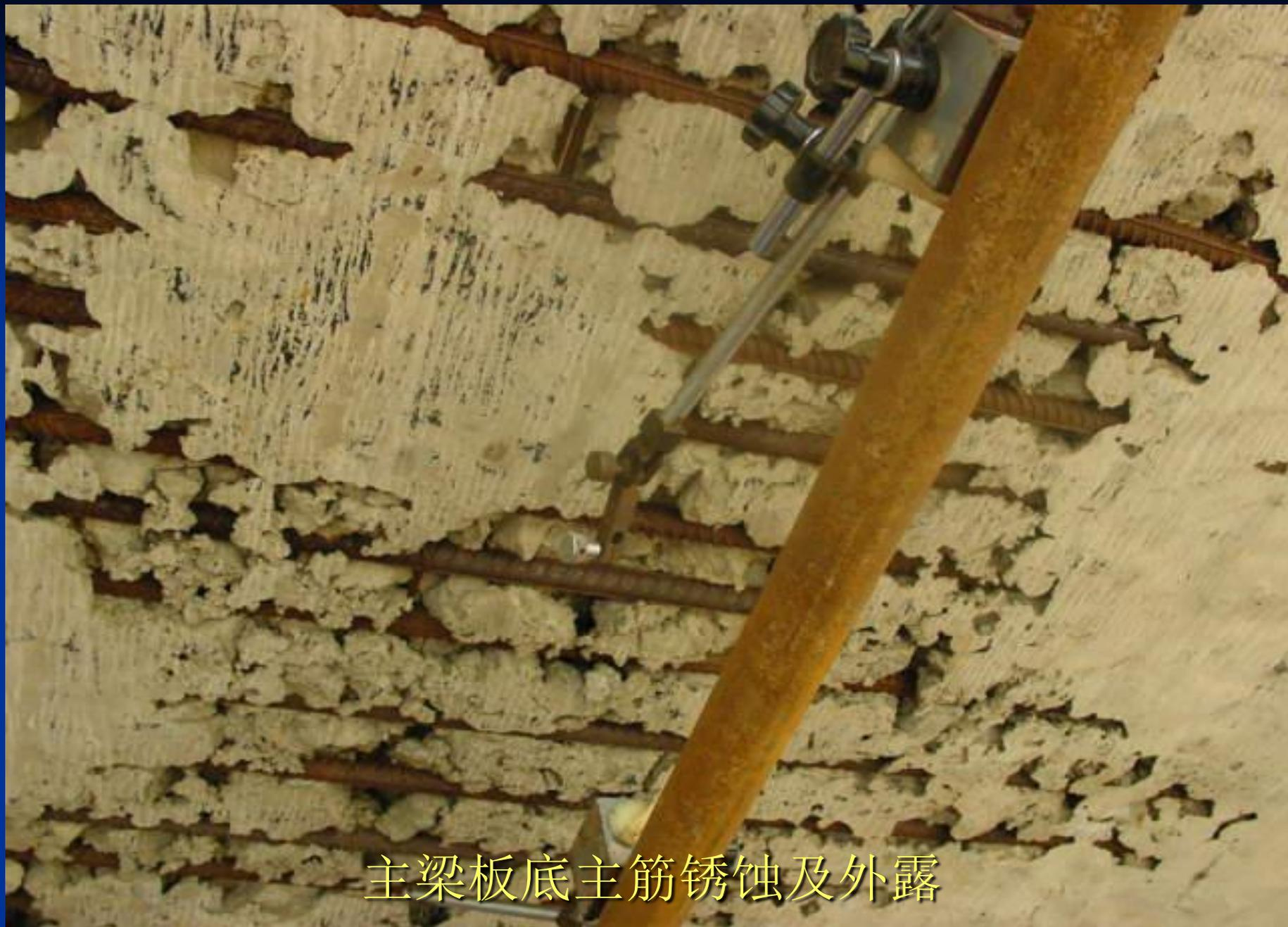
主梁板底主筋锈蚀及外露
