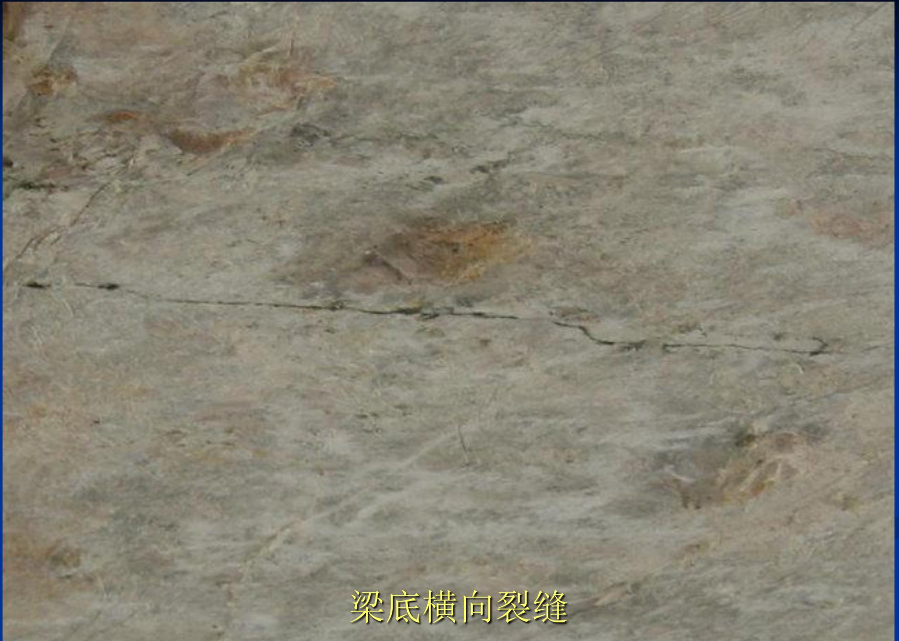
梁底横向裂缝
