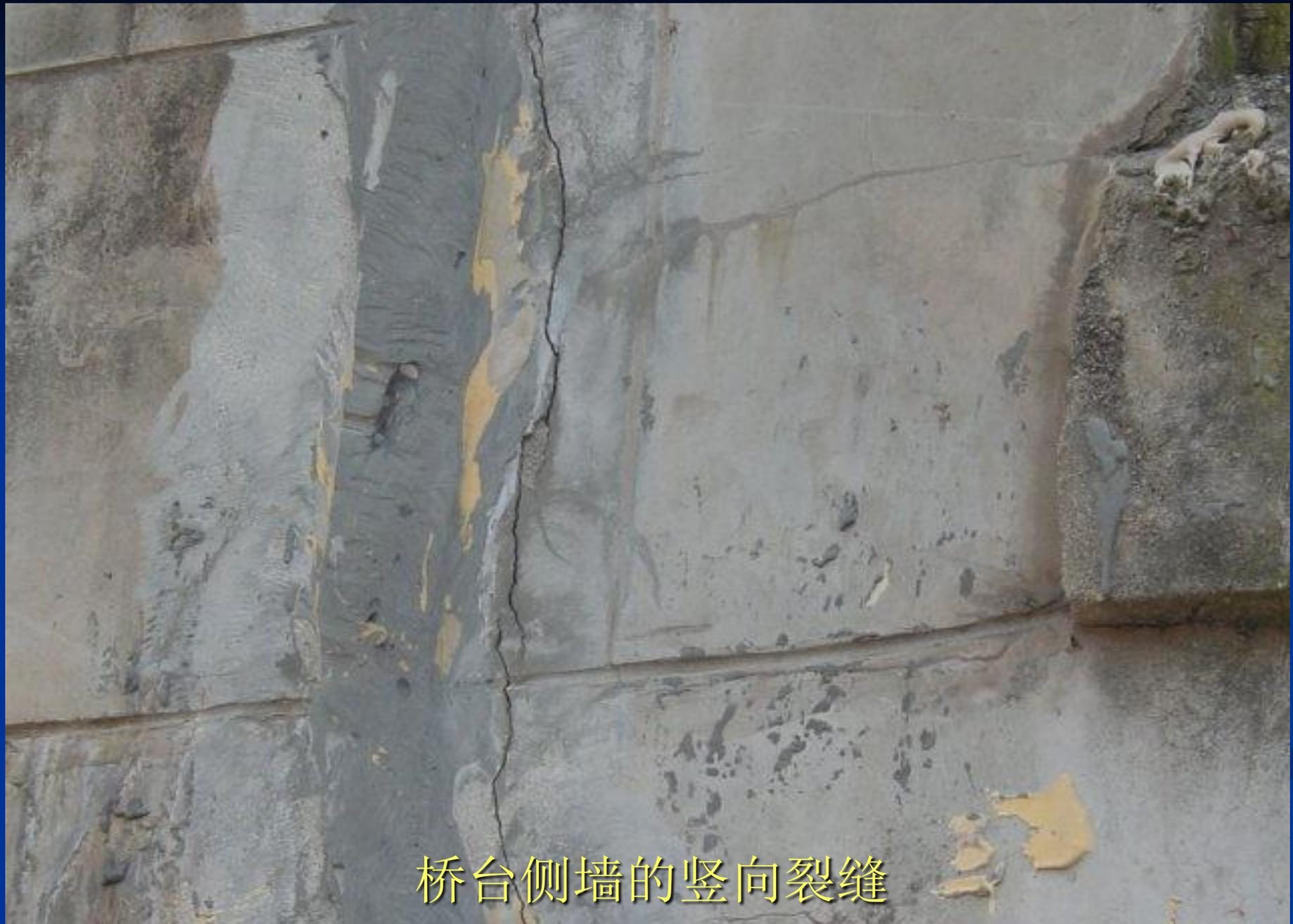
桥台侧墙的竖向裂缝
