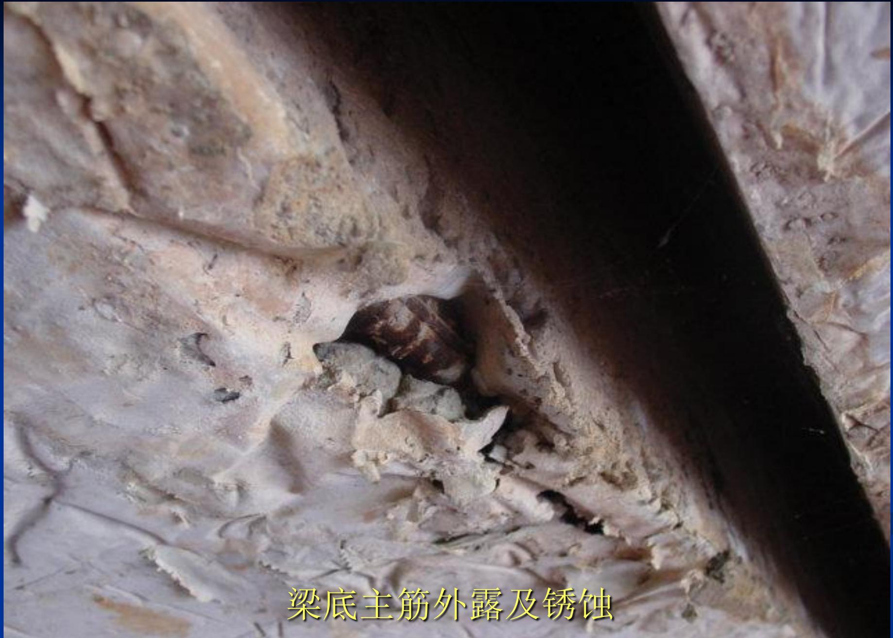
梁底主筋外露及锈蚀
