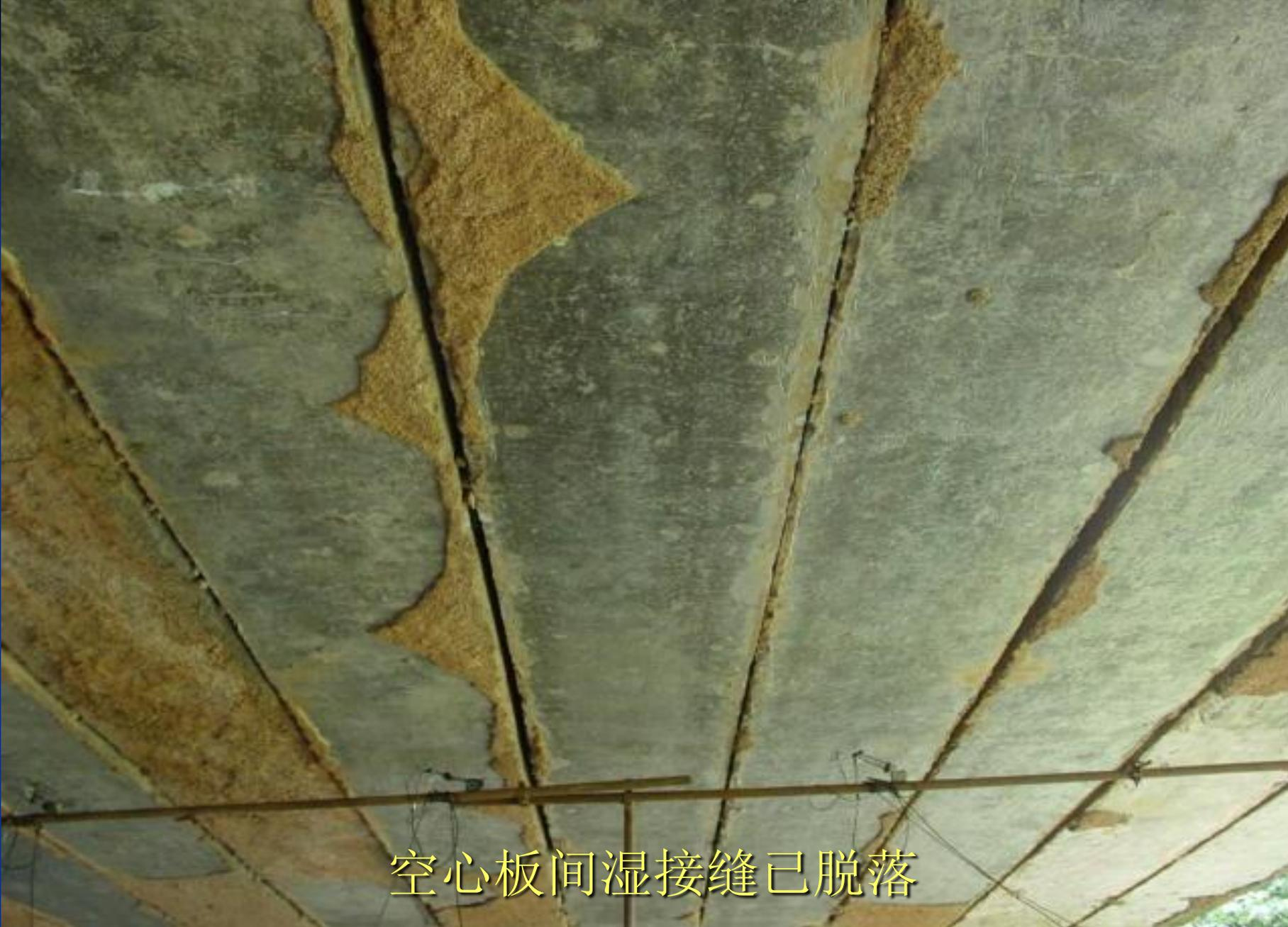
空心板间湿接缝已脱落
